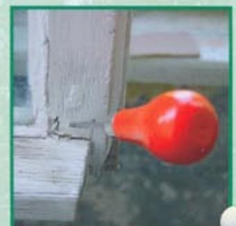
Lang anhaltende Feuchtigkeitseinflüsse führen zu einer Holzschädigung.
